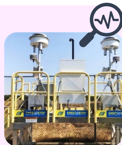
Estación de monitoreo.
